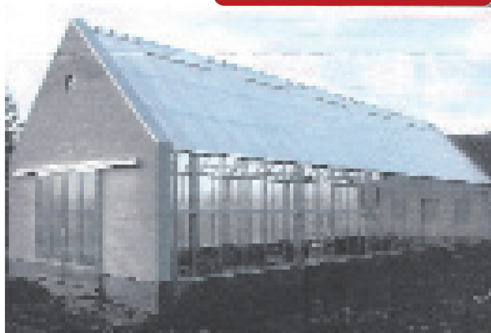
En tiloversbleven sidebygning er omdannet til drivhus. Bygningen har ændret karakter, men den plads den har i forhold til omkringliggende bygninger er bevaret.
