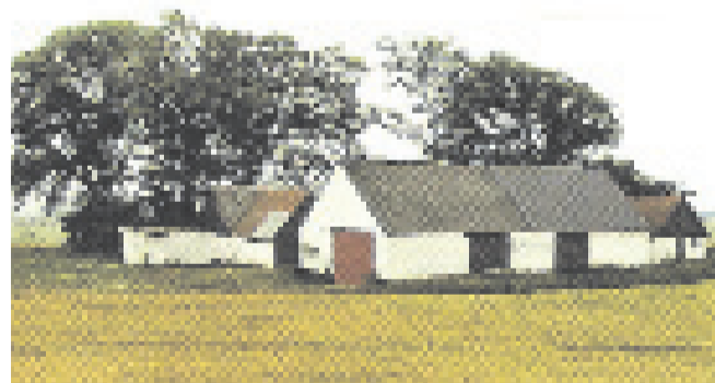
Et gammelt gårdanlæg trængte kraftigt til renovering.
